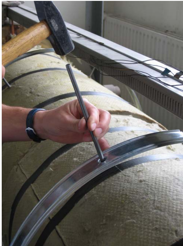
Bild 5: Montage der Stürzring am Prüfrohr
